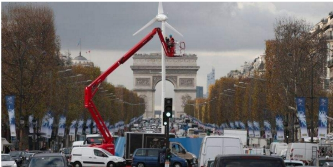
Ultimes réglages avant la mise en marche de l'éolienne.
